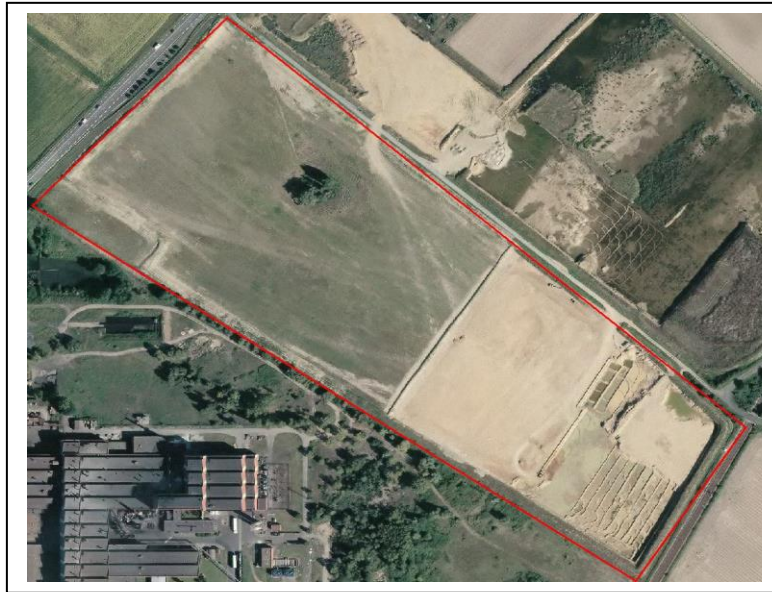
Photo : état de la parcelle pendant de l'activité d'exploitation minière (sable et galets)
